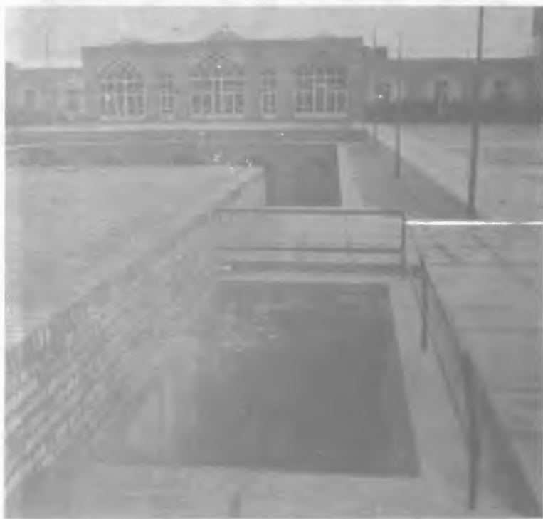
۹۳ — یزد: مدرسه مصلی، راه پله منتهی به طبقه زیرزمین
