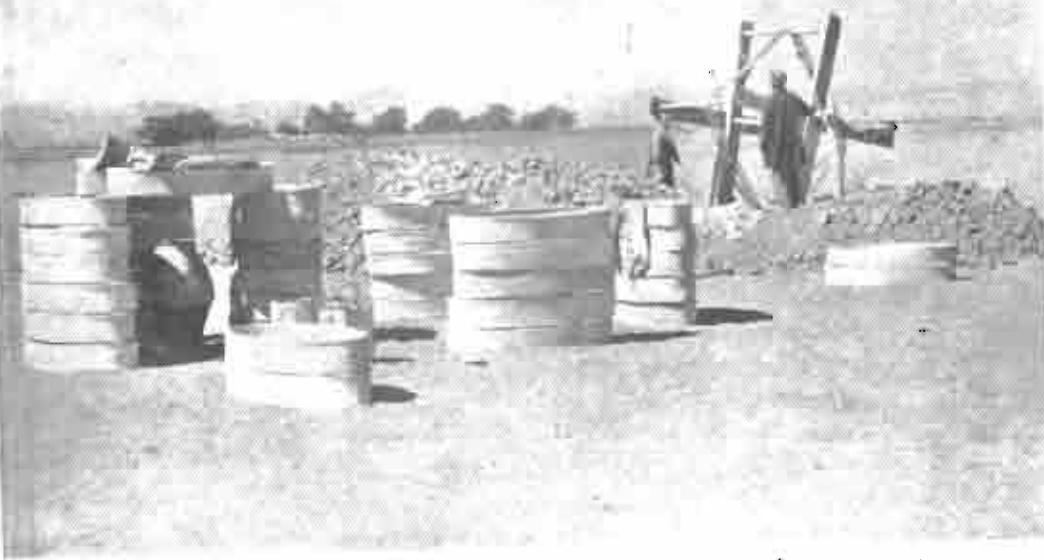
۸: یک جرخ‌جاه که در مدخل یکی از میله‌های قنات قرار گرفته است. قسمت ناحیه زمین این منطقه است بوده و هنوز ها رای حفر کالالهای قنات (کوره‌ها) از «بار» استفاده نمی‌کردند. بارها که روی زمین رویهم جسته شده‌اند، غریب نموده دیده می‌شود.
