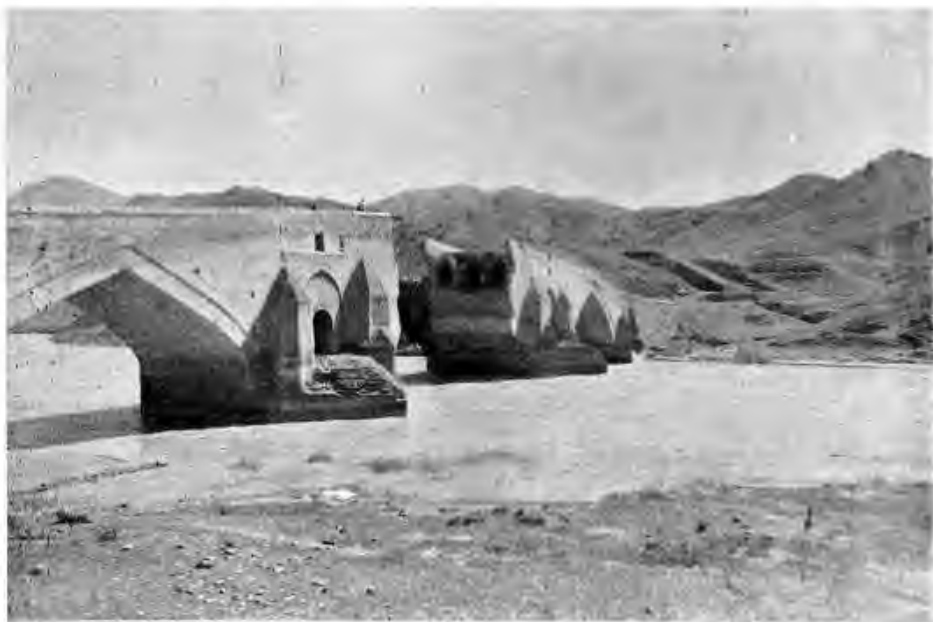
۴۱ - پل دختر - در نزدیکی میانه که از وسط بعلت بمب شکسته شده است .
