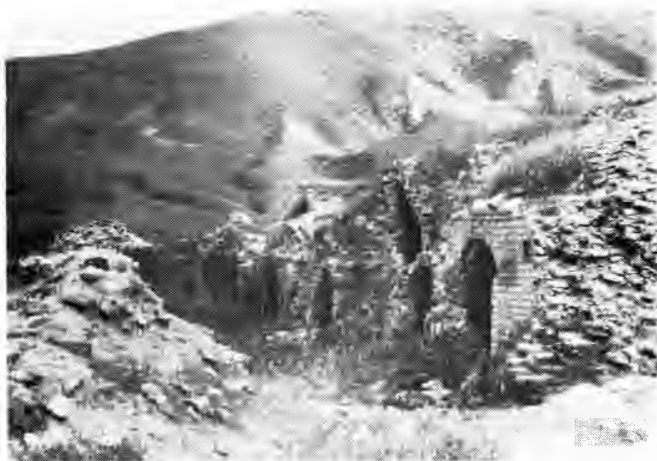
۷۹ - خرابه‌های کاروانسرای در بیست کیلو متری جنوب غربی اهر
