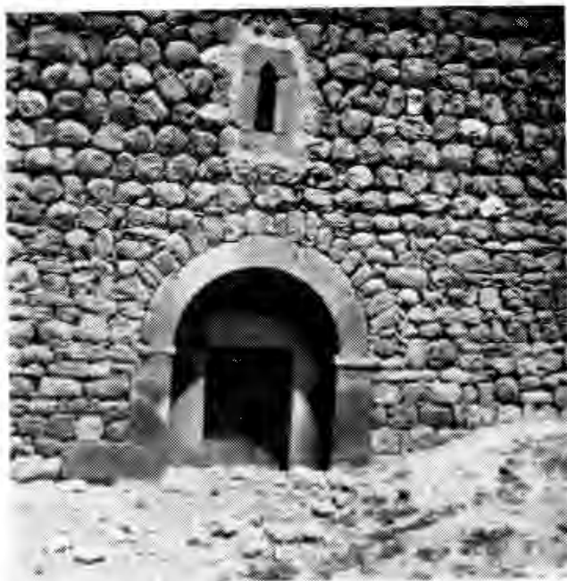
۷۲ - تصویر در ورودی کلیسای موجومبارکه از سنگ تراش ساخته شده است .
