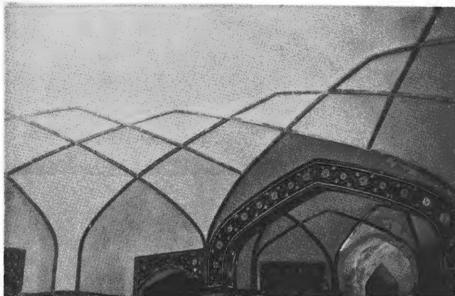
کاشی کاری تجدید بنا داخل حمام
