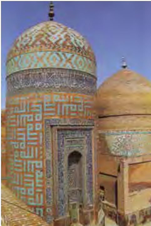
تصویر شماره ۵-۱۲- گنبد الله الله، بقعة شیخ صفی‌الدین اردبیلی در اردبیل، کاشی درهم (معقلی)
