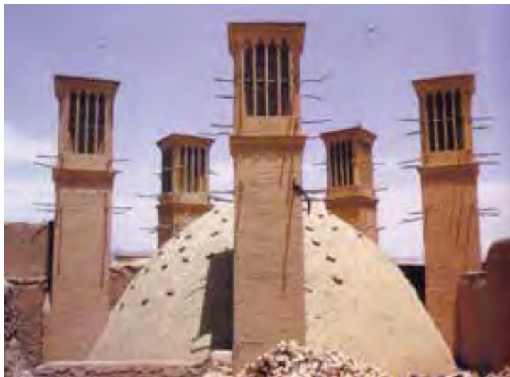
تصویر شماره ۲-۵۰- آب انبار و بادگیرهایش
