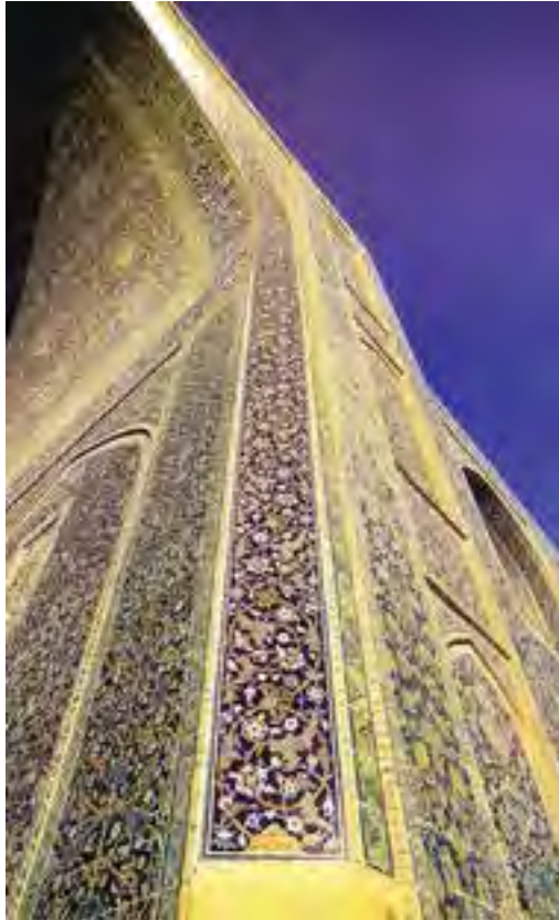
تصویر شماره ۱۰-۵- ایوان شمالی مسجد امام اصفهان، کاشی‌کاری پخی دیوار از نوع معرق و متفاوت با دو بدنه مجاورش می‌باشد.
